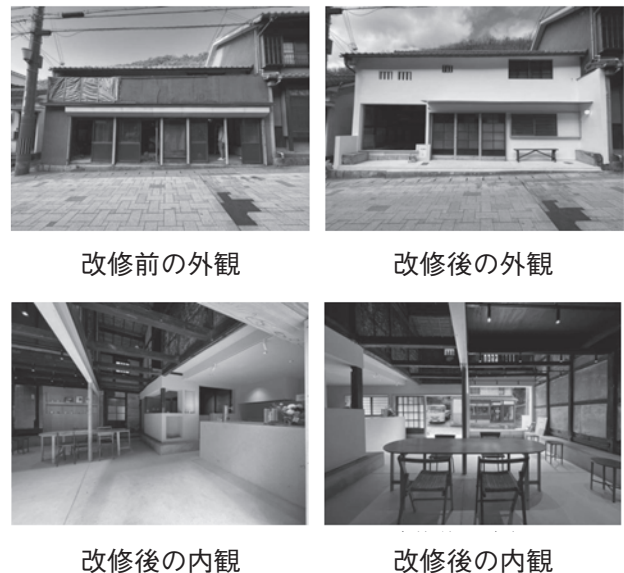
赤穂市坂越地区の明治時代の建物を、物販店舗から飲食店、ホテル・旅館、事務所の複合用途に改修した事例
