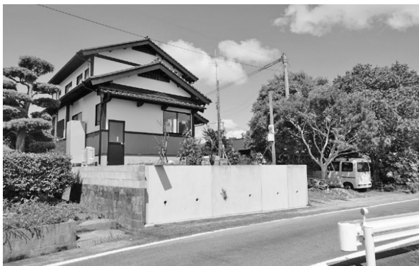
写真1 2019年と2021年の水害で連続被災をした佐賀県武雄市における個人宅地嵩上げによる住宅耐水化の事例（2022年6月、著者撮影）
