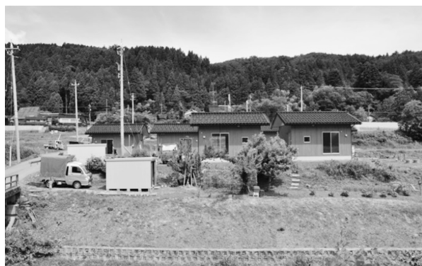
写真6 穴水町下唐川の戸建木造仮設住宅、山側に被災家屋が立ち並ぶ(2024年6月、著者撮影)
