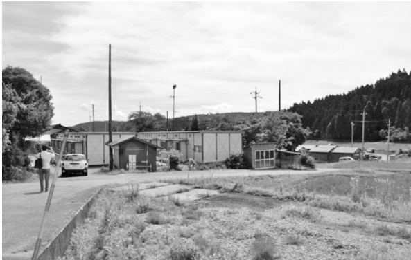
写真7 穴水町下唐川のプレファブ仮設住宅、奥に見えるのが戸建木造仮設住宅（2024年6月、著者撮影）
